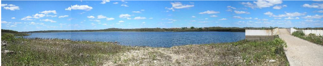
Figura 8 – Vista geral do açude Marengo
