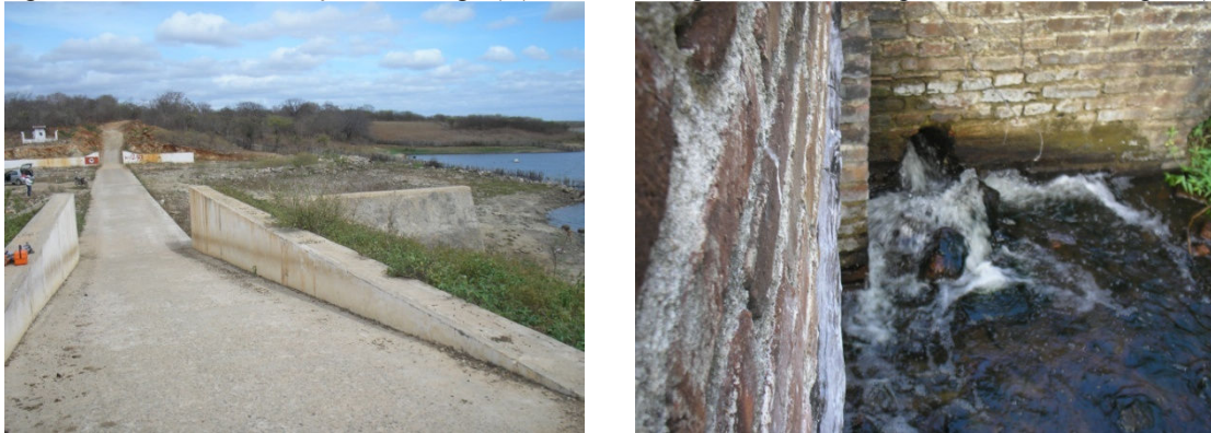
Figura 9 – Vertedouro do açude Marengo (A) e tomada d'água localizada na parte central da barragem (B)
