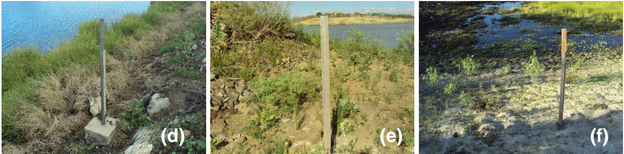
Figura 14 – Réguas linimétricas instaladas para a mediçãod e nível nos açudes. (a) Açude da Lagoa Cercada, (b) Açude do Cambito, (c) Açude do Riacho Verde, (d) Açude do Algodão, (e) Açude da Campina, (f) Açude da Vista Alegre.
