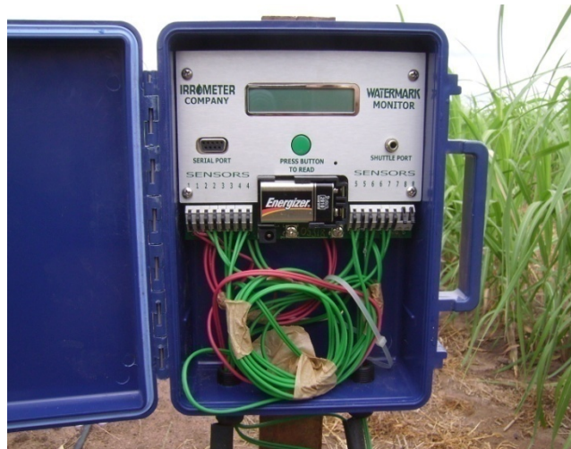
Figura 7 – Estação utilizada no monitoramento do potencial da água do solo.
