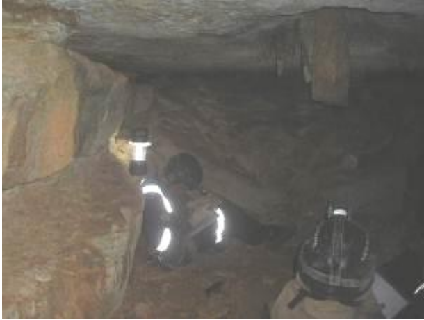
Figura 52 – Desplacamento horizontal e desmoronamento do teto.
