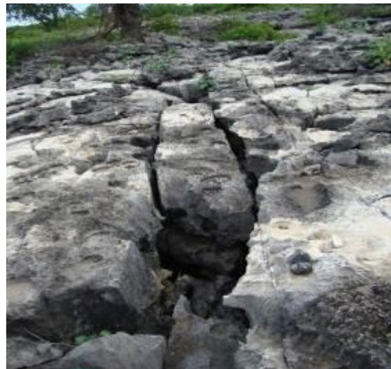
Figura 90 – Fraturas interligadas de direção NW-SE.(Coord. 652406/9389791).
