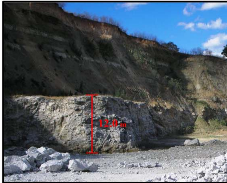
Figura 5.2 – (a) Espessura de 12 metros da camada de gipsita. (b) Nesta figura a porção argilosa está encoberta por sedimentos de escorregamento do membro Romualdo.
