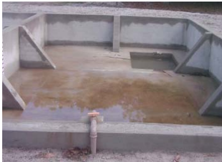
Figura 10 – Viveiro experimental para piscicultura construído em alvenaria no Centro Experimental de Reúso de Águas da CAGECE, Aquiraz, Ceará, 2007.
