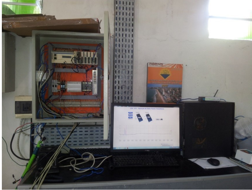
Figura 59 – Supervisório de medição de temperatura e irradiância solar
