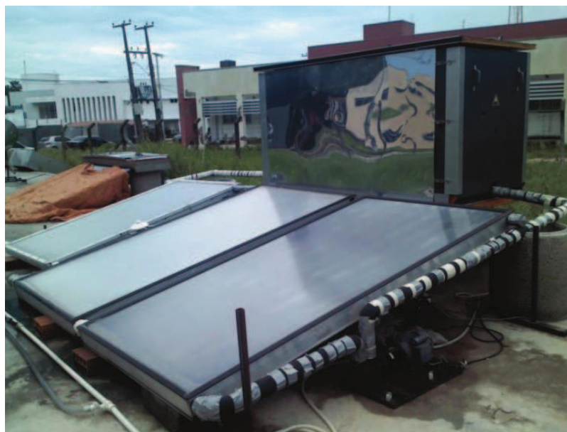
Figura 3.7 – Dessalinizador solar com recuperação de calor
