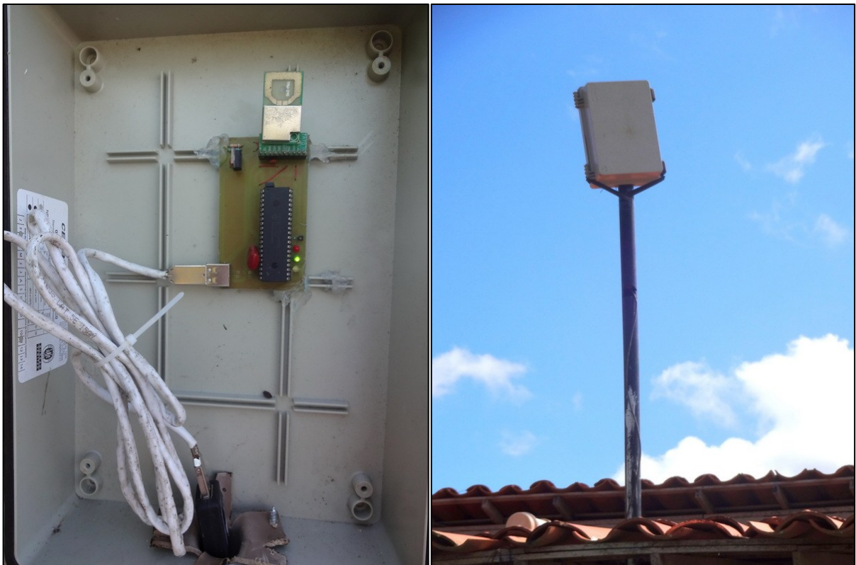
Figura 39 – Módulo mestre instalado (à direita) e detalhe da instalação (à esquerda)
