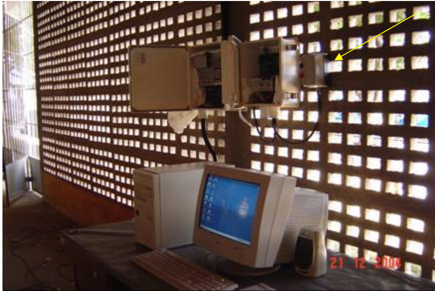
Figura 15. Chave de partida utilizada no tratamento não automático.
