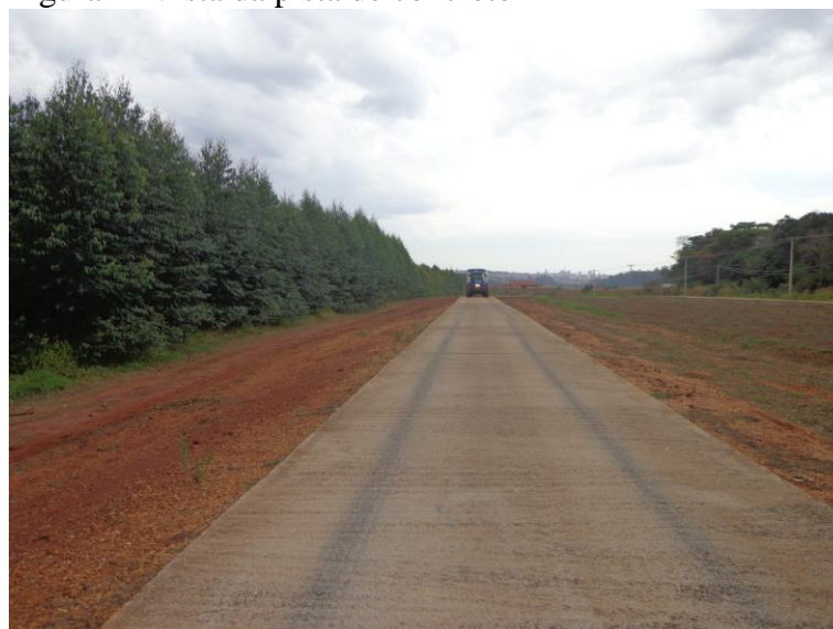
Figura 1- Vista da pista de concreto
