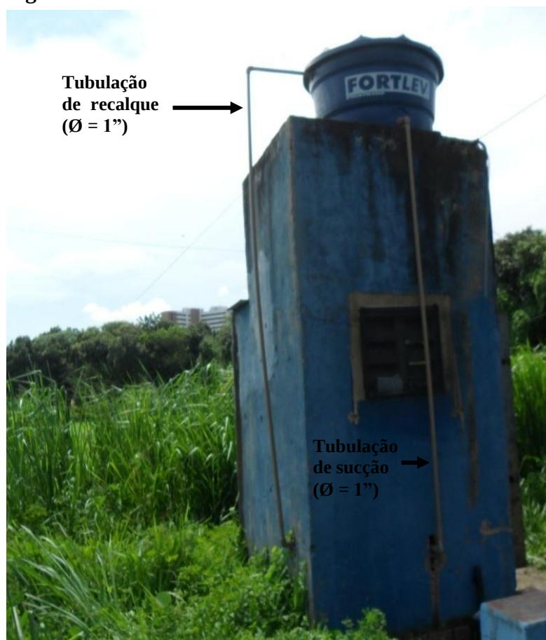
Figura 12 - Estrutura com o reservatório elevado
