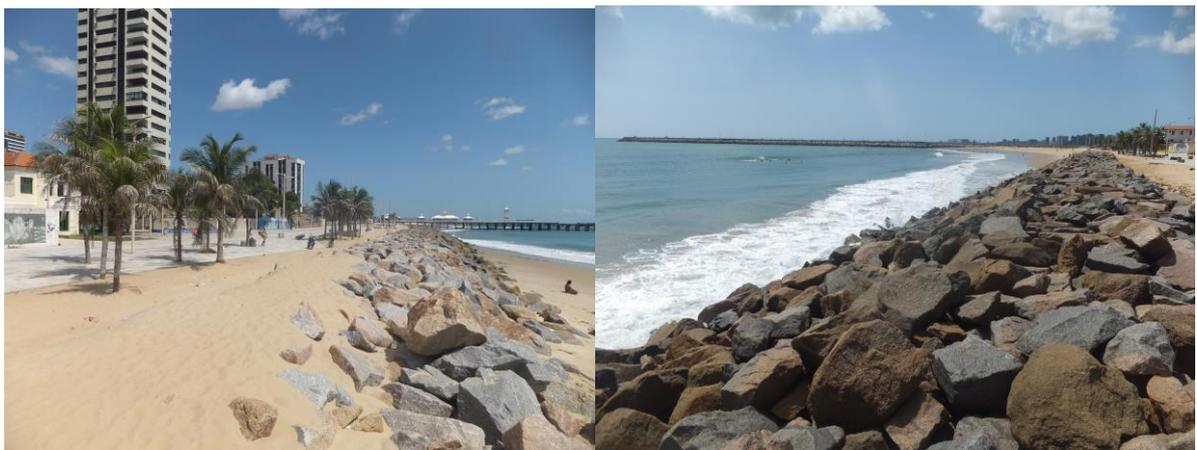
Figura 25: Obras de contenção à erosão (enrocamento). Fonte: Autor.
