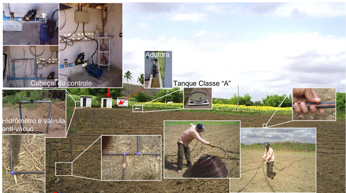
Figura 8 - Instalação do sistema de irrigação e seus componentes. FEVC, Pentecoste, CE, 2007.
