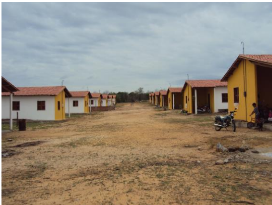
Fig. 09: Casas construídas no Município de Iracema-Ce.
