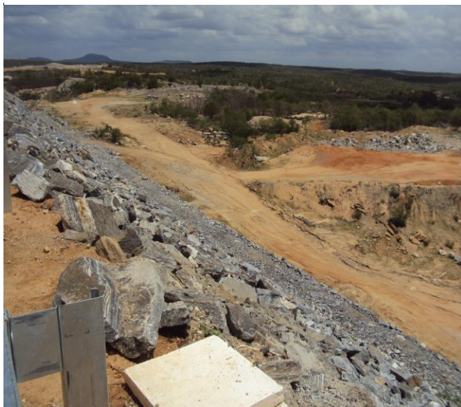
7.6. Parede da Barragem do Figueiredo.
