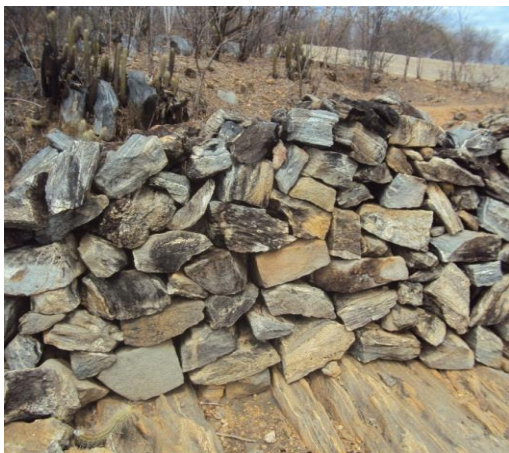
Fig. 07. Cerca de pedra dentro do assentamento Boa Esperança
