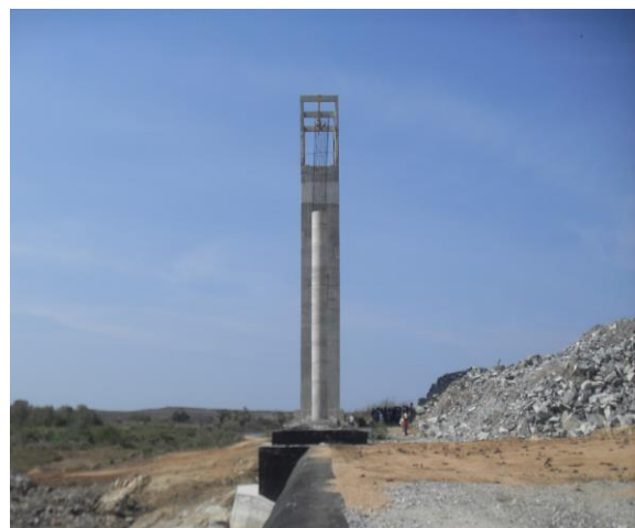
Fig. 04. Início das construções da Barragem do Figueiredo.
