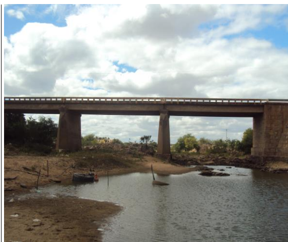
Fig. 03. Ponte sobre o Rio Figueiredo no Município de Iracema-Ce.
