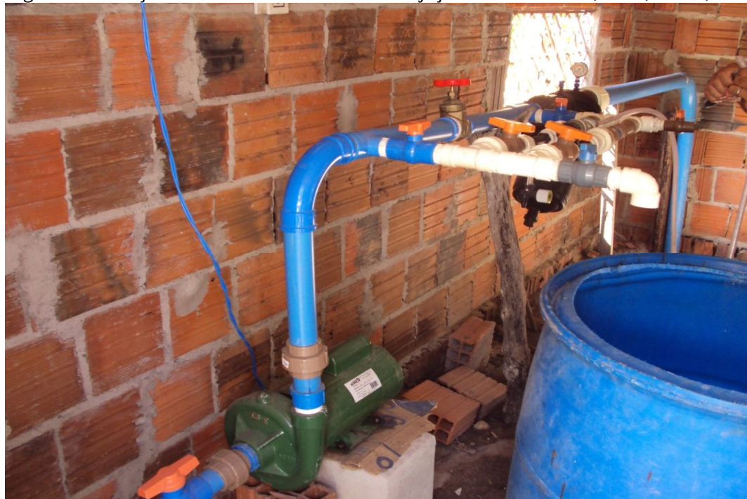
Figura 5 - Cabeçal de controle com sistema de injeção de fertilizantes, Cruz, Ceará, 2010.
