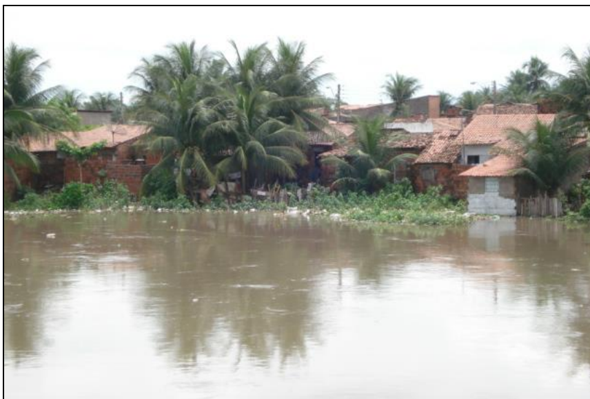
Figura 20. Ocupação as margens do rio Maranguapinho - Áreas de risco no período de chuva. Foto: Maia (2009).
