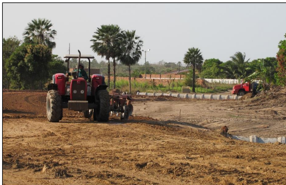
Figura 33. Obras de implantação de vias de acesso entre os municípios de Maracanaú e Fortaleza. Foto: Maia (2015).
