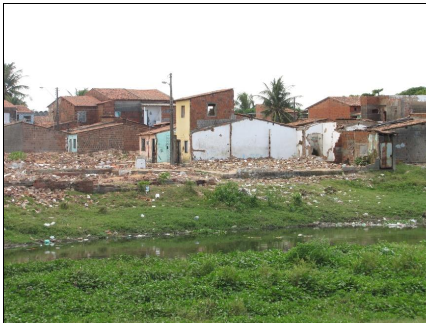
Figura 46. Retirada da ocupação indevida na planície fluvial do rio Maranguapinho – Trecho I – bairro Autran Nunes. Foto: Maia (2010).
