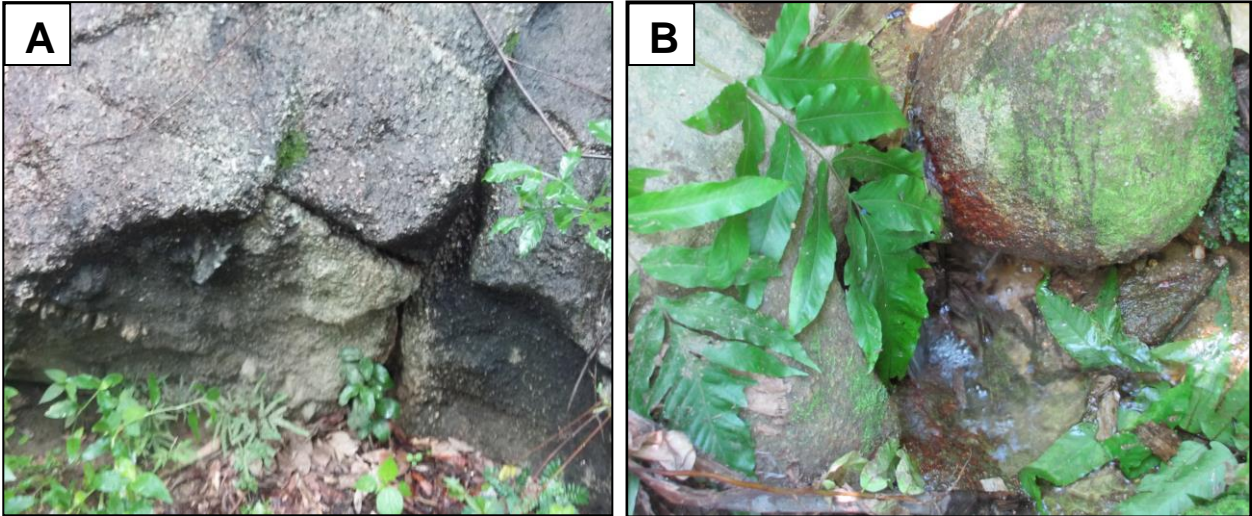
Figura 4. A) Ruptura dos blocos rolados pela ação do intemperismo físico; B) Intemperismo físico e químico através da oxidação da rocha decorrente da ação pluviométrica. Foto: Maia (2015).
