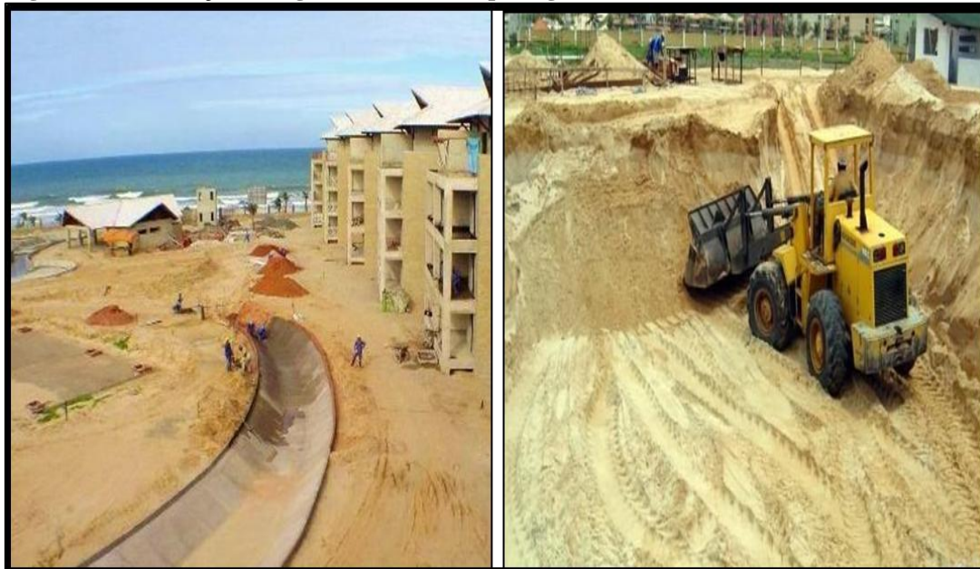
Figura 53. Construção do lago artificial e terraplanagem sobre a área de dunas.
