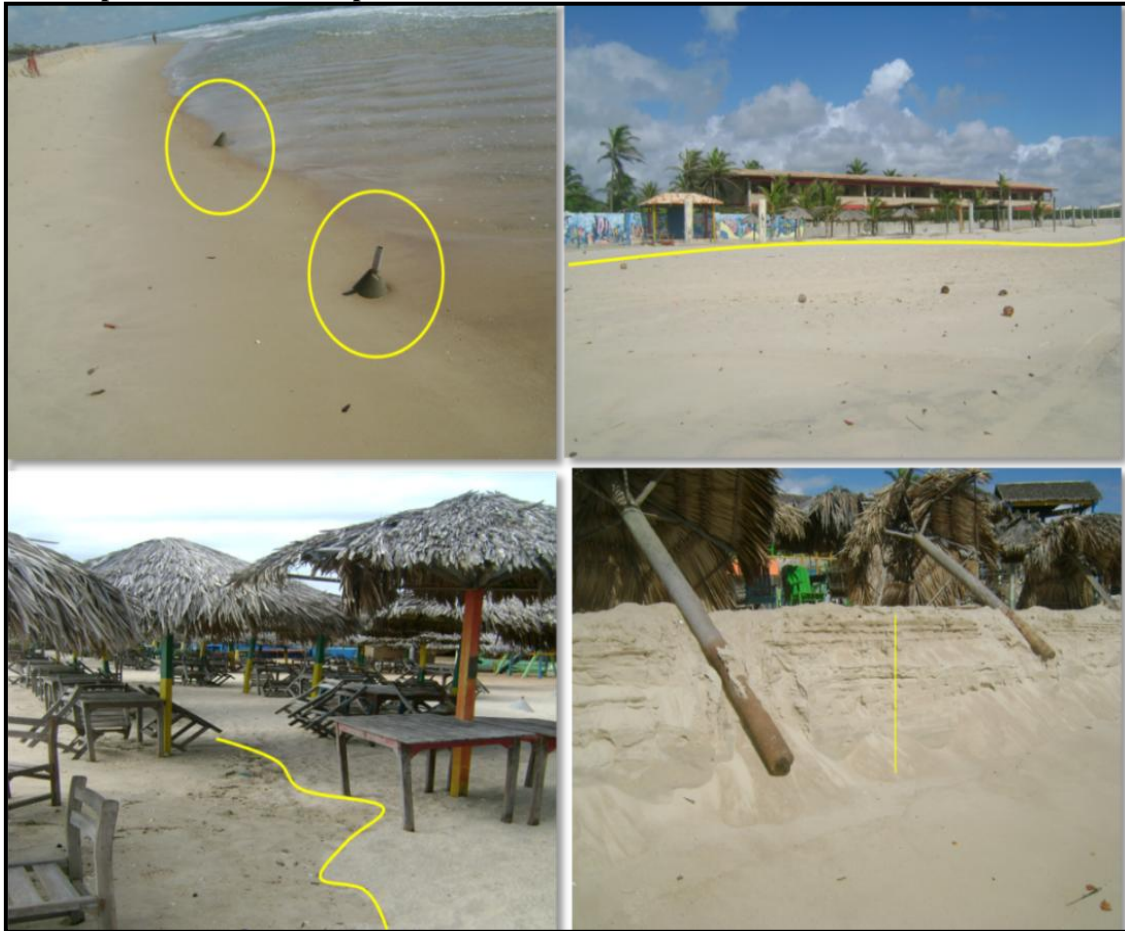
Figura 50 - Trechos da Prainha de Aquiraz com ação das ondas sobre as construções e barracas de praia. Na sequência, suportes de guarda-sol no estirâncio; linha de premar frente ao parque aquático Itacaranha Park ; dinâmica da maré em sua área de atuação com ocupação e; barraca de sol caída pela retirada de areia por ondas.
