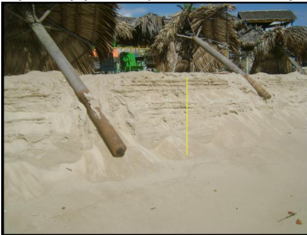
Figura 08 - Ocupações de barracas e estruturas na pós-praia. A posição e o desenvolvimento da escarpa no limite da pós-praia indica a atuação e o alcance das ondas na Prainha de Aquiraz.
