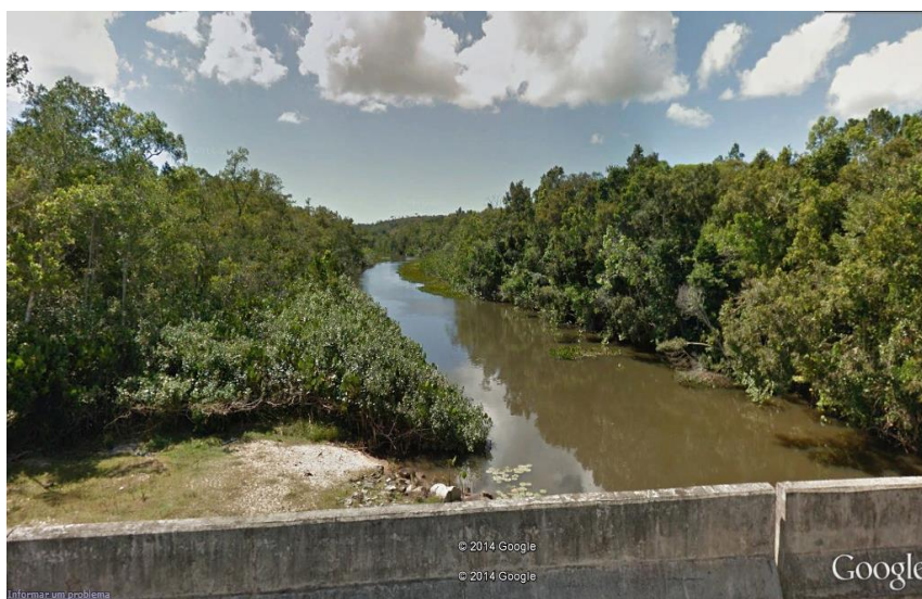
Figura 26 – Ponte sob a BA-683, no sentido de Santa Cruz Cabrália.
