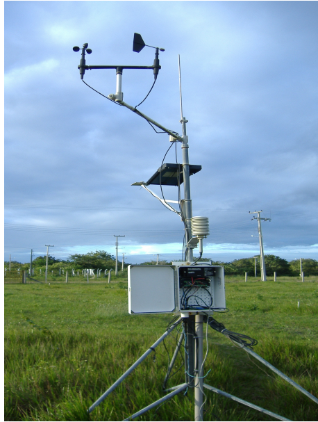
Figura 8 – Estação meteorológica automática, instalada no Distrito de irrigação
