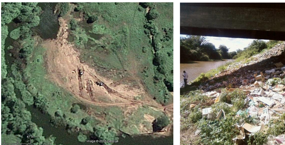
Retirada de areia e lixo na ponte que liga Sousa a Uiraúna. Fonte: Google
