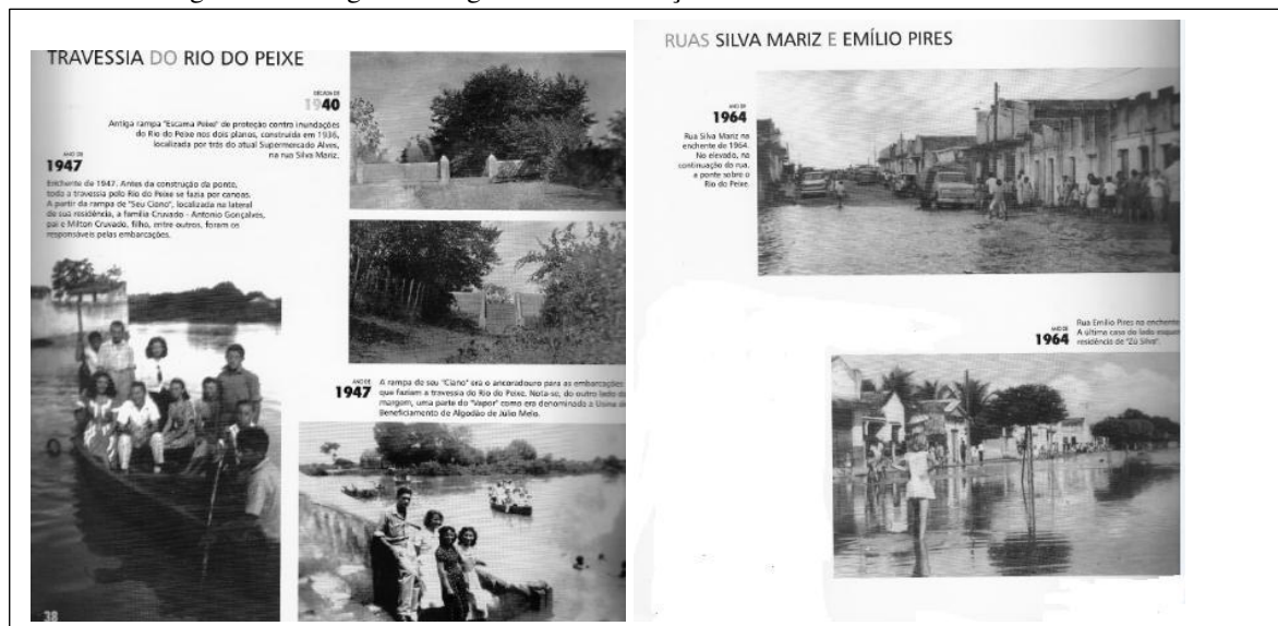
Figura 32 – Registro fotográfico de inundações de 1947 e 1964.
