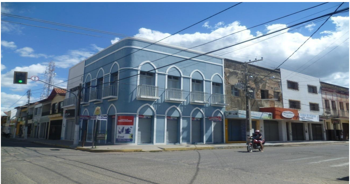
Figura 27 - Sobrados em Aracati (Fonte: PEDROSA, 2015).
