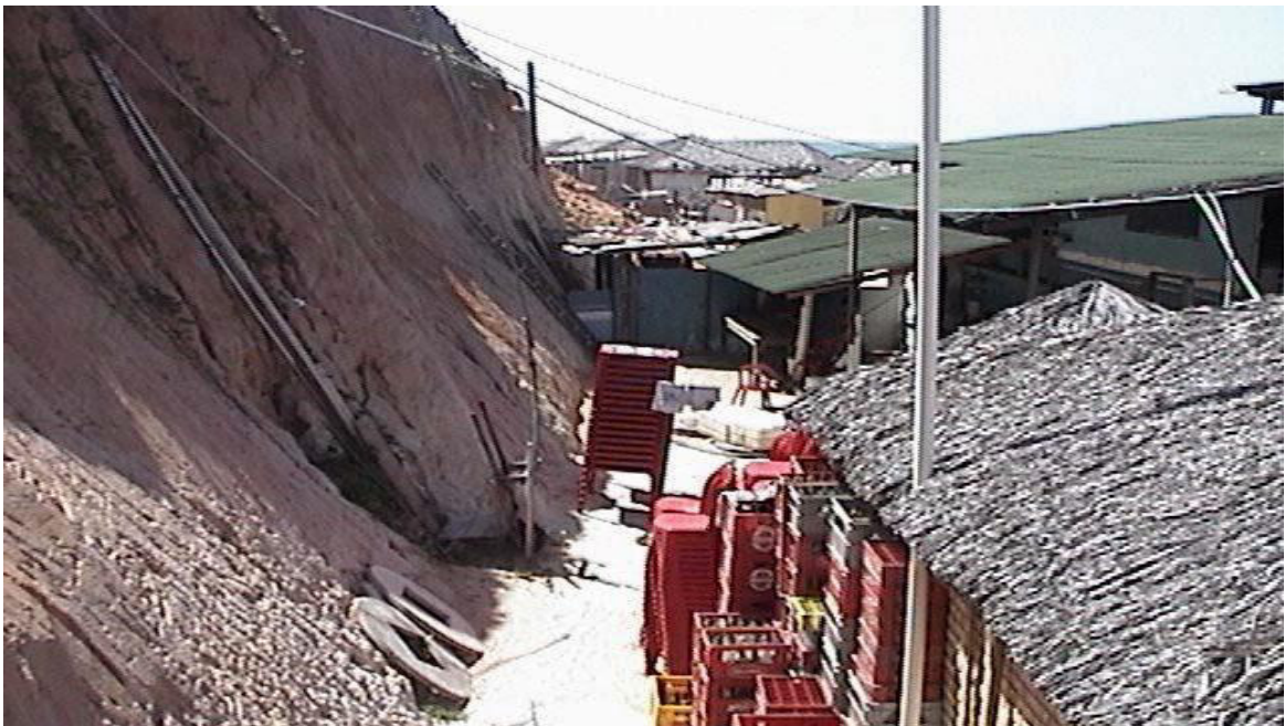
Figura 39 – Sopés das falésias nos fundos das barracas utilizados para armazenamento de entulho ou instalação de tanques de esgoto- Canoa Quebrada. (Fonte: Projeto Canoa, 2002).
