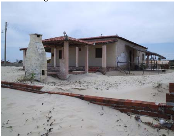
Foto 27. Segundas residências abandonadas
