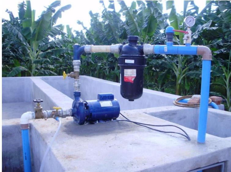
Figura 7 – Cabeçal de controle da irrigação e da fertirrigação utilizado na realização do experimento.
