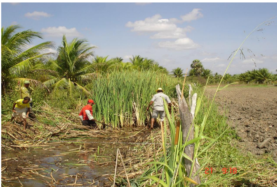
Figura 7 - Coletor antes da limpeza (fonte de recarga).
