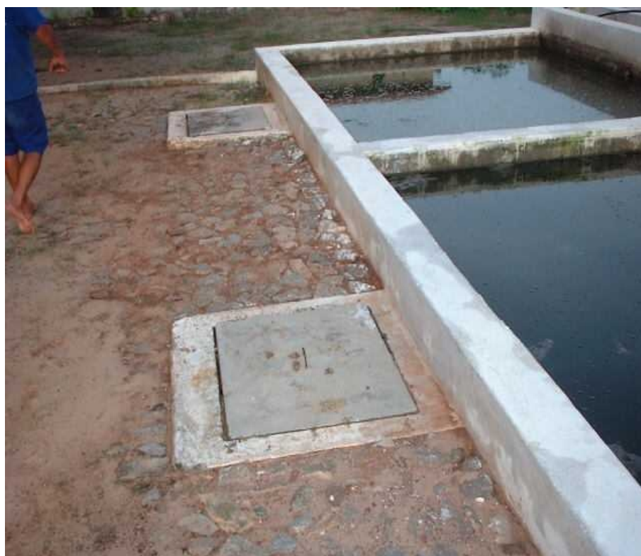
FIGURA 80 – Leito de Secagem
