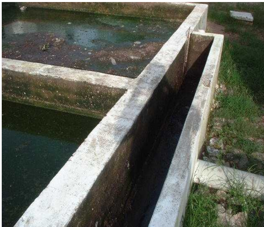
FIGURA 81 – Leito de Secagem
