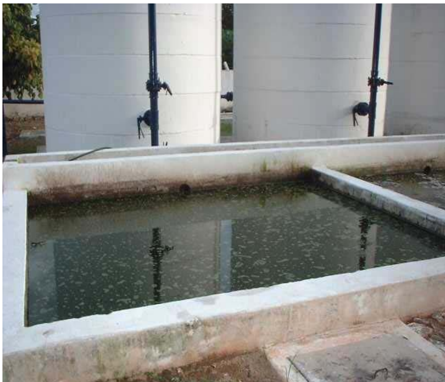
FIGURA 83 – Sistema de Reatores e Leitos de Secagem
