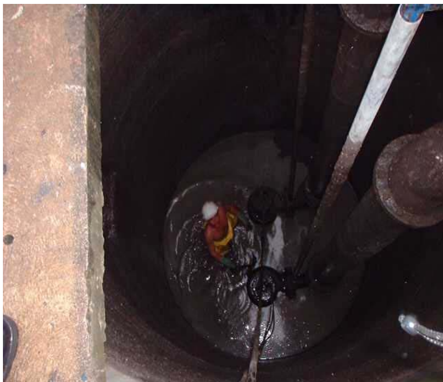
FIGURA 84 – Sistema de Bombas e Poço de Sucção
