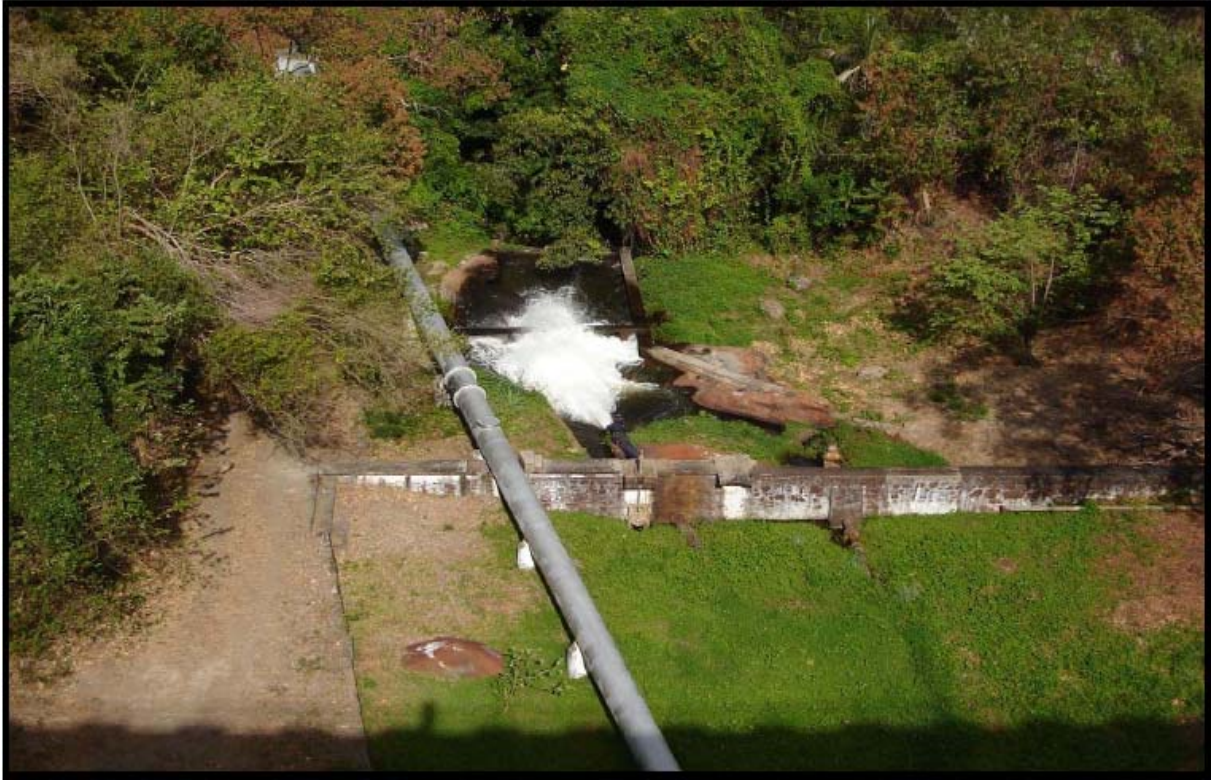
Figura 3.10 – Saída da adutora a jusante da barragem do Açude Acarape do Meio (esquerda). Saída d'água para curso natural do Rio Pacoti a jusante (direita). Fonte: RIBEIRO, 2007.
