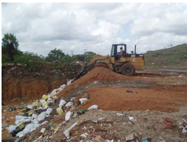
FIGURA 22 – Trator compactando o lixo
