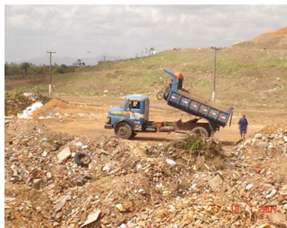
FIGURA 25 – Iluminação da área de descarregamento de lixo
