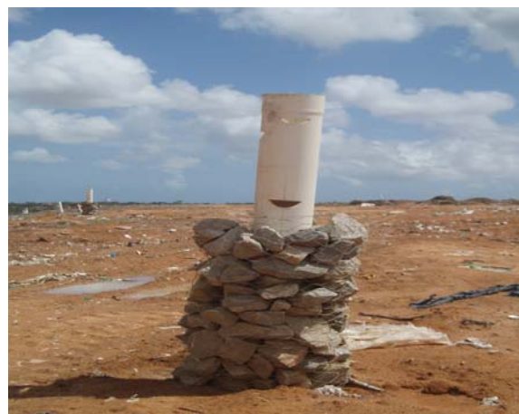
FIGURA 23 – Drenos para coleta de gases
