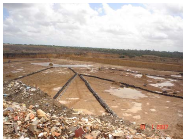
FIGURA 20 – Célula para disposição do lixo, com canaletas para coleta do chorume
