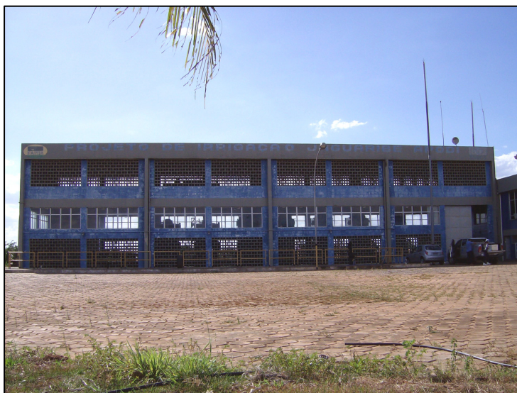
FIGURA 11 – Estação de bombeamento principal (Fonte: Acervo da pesquisa).
