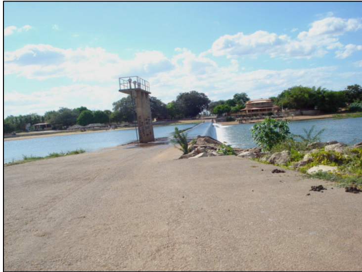
FIGURA 9 – Barragem de Pedrinhas, no município de Limoeiro do Norte, CE (Fonte: Acervo da pesquisa).
