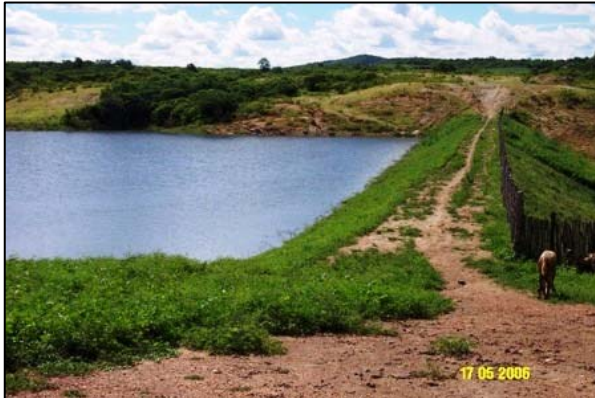
Figura 2-9: Reservatório de L.Cercada.
