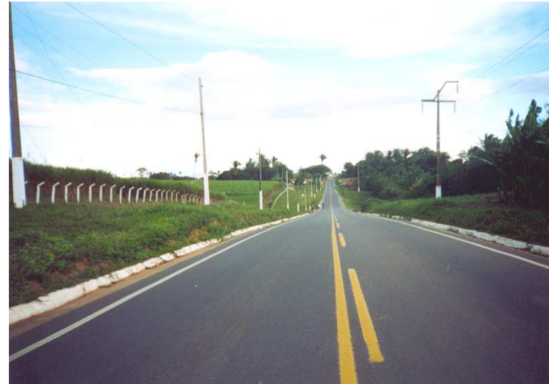
Figura 10: CE 187 – Trecho São Benedito ► Ibiapina Trecho 1
