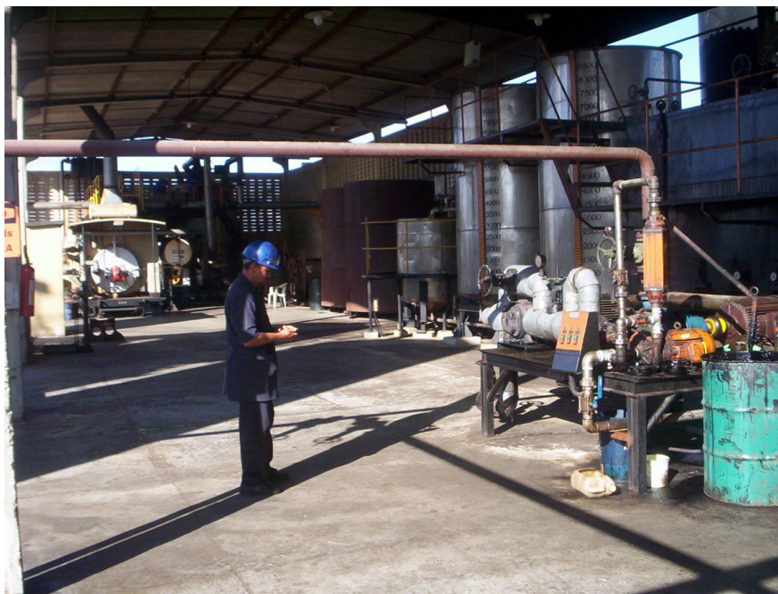
Figura 2.5 - Instalação de uma fábrica de emulsão asfáltica.
