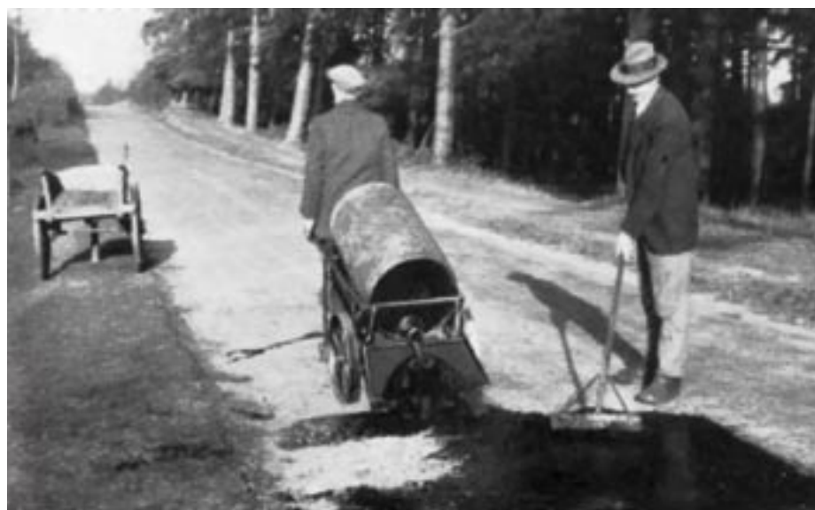
Figura 2.1 - Aplicação de emulsão asfáltica no início do século XX (Omena e Antoszczem Junior, 2006).
