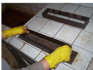
Montagem da fôrma
