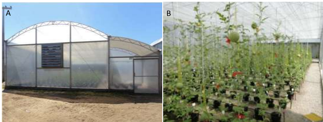
Figura 1. Casa de vegetação utilizada para condução do presente experimento: A) Vista externa da casa de vegetação; B) Vista interna da casa de vegetação já com o cultivo de minimelancia ( Citrullus lanatus ).
