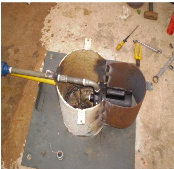
Figura 17 - Montagem do conjunto elevatório
