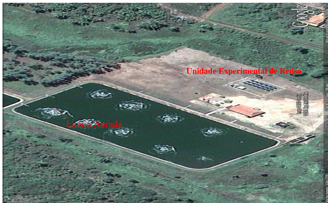
Figura 12 - Vista aérea ETE da Zona Leste de Teresina (Google, 2009). Destaque para Lagoa Aerada e Unidade Experimental.
