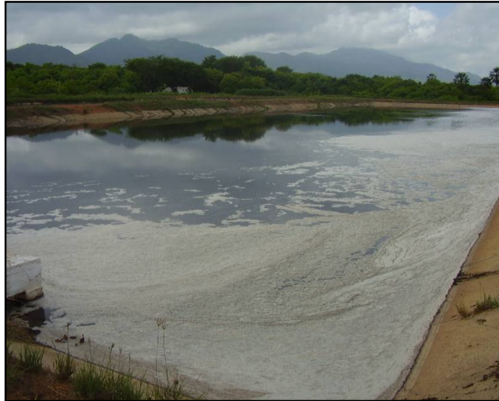
Figura 3.3: Lagoa anaeróbia na entrada do sistema de tratamento por lagoas de estabilização do ASMOC.
