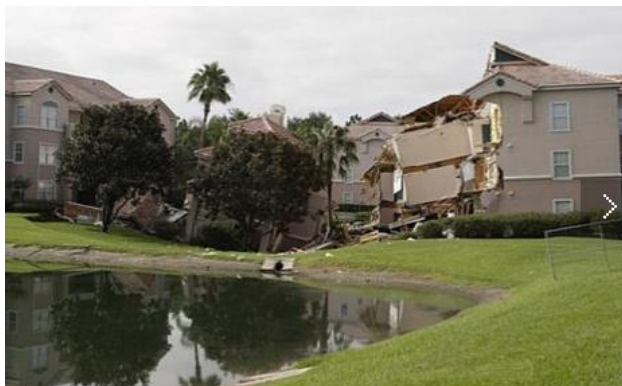
Figura 8 – Foto de desabamento de hotel .
