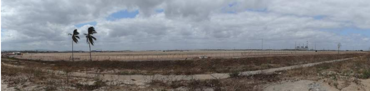
Figura 22: Terraplanagem da Companhia Siderúrgica do Pecém - CSP
