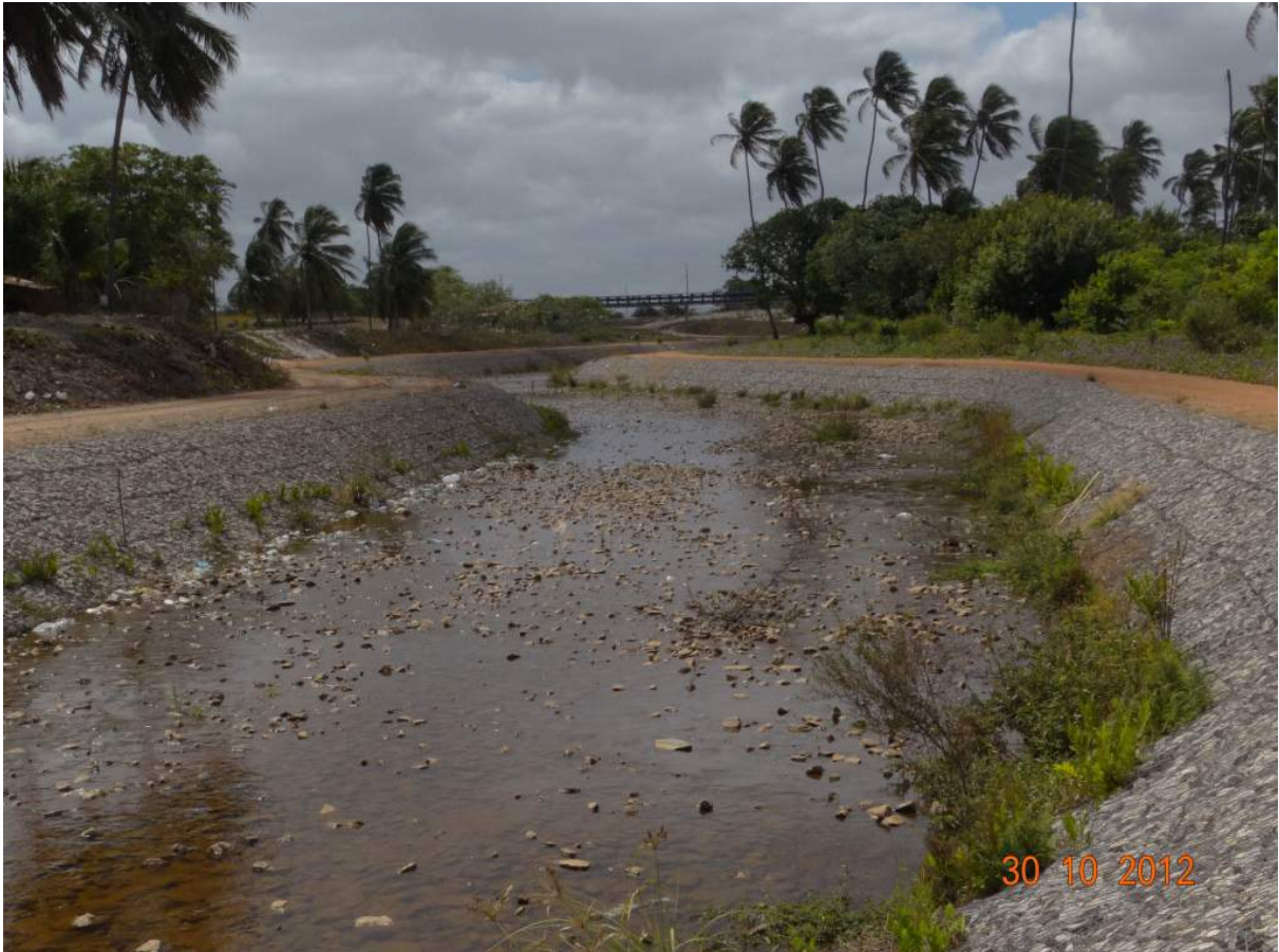
Figura 23: Canalização e impermeabilização do afluente Bom Jesus do rio Guaribas, presente na localidade do mesmo nome (pertencente ao Distrito do Pecém).
