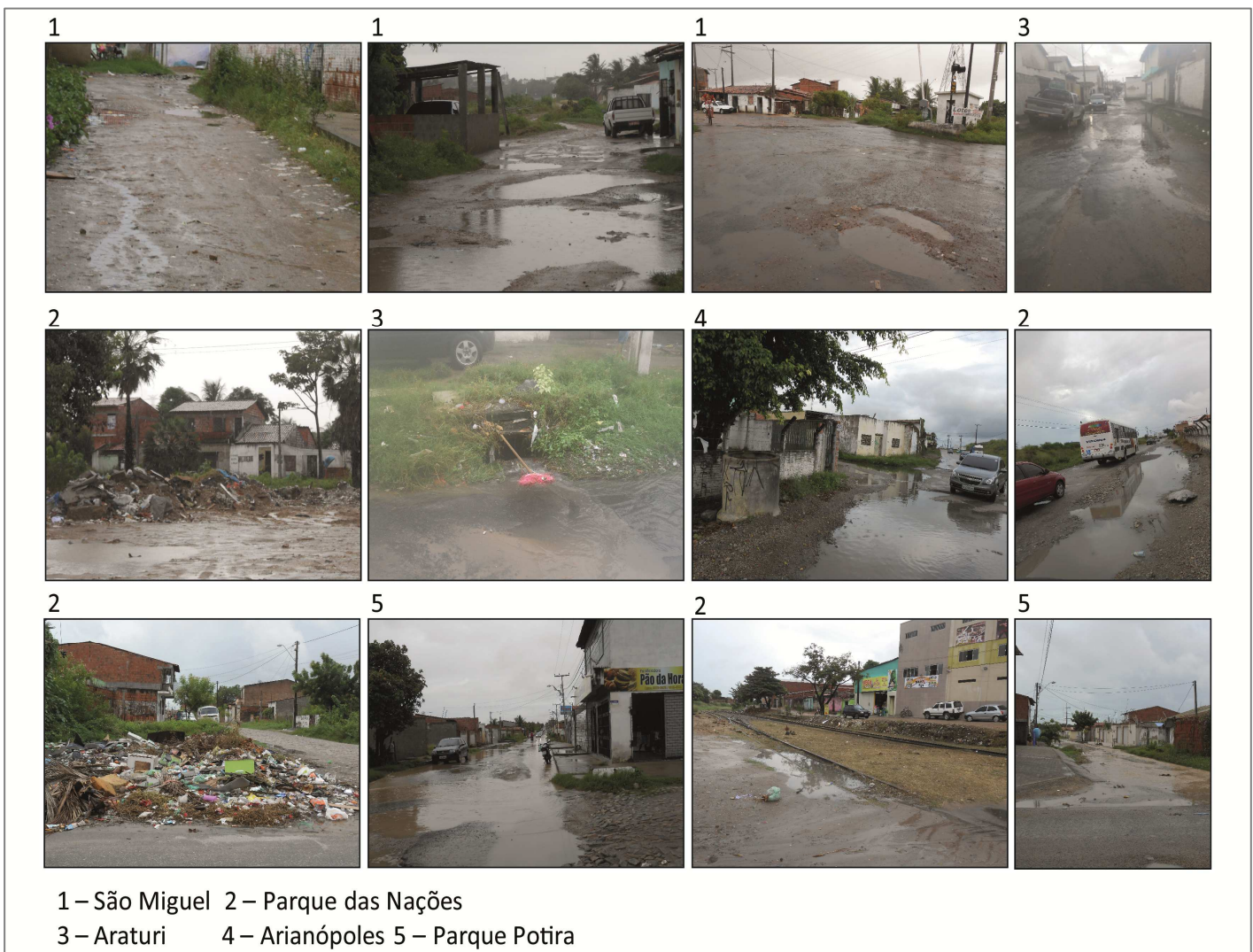
Imagem 3 – Situação dos bairros do distrito de Jurema / Caucaia – CE
