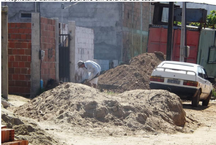
Figura 9 – Proprietário auxiliando pedreiro em obra na sua casa
