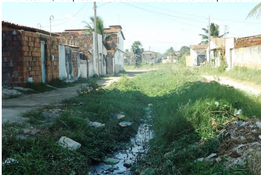
Figura 12 – Travessa 14, vala passa no meio da rua trazendo incomodo para os moradores
