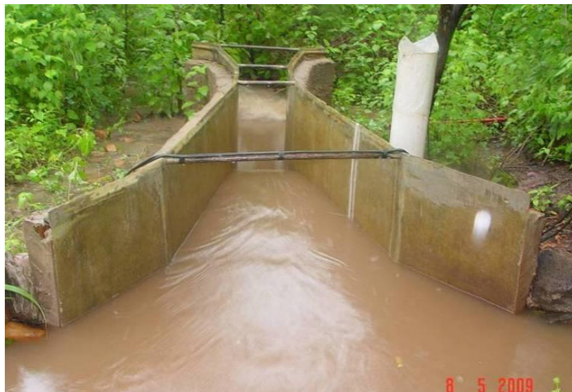
Figura 15 – Calha Parshall em fibra de vidro, nas microbacias experimentais, Iguatu-CE Fonte: Adaptado de Rodrigues (2009)
