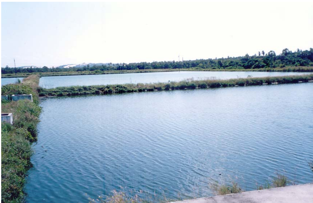
FIGURA 4.3 – Lagoas anaeróbia e facultativa da ETE de Aquiraz, Ceará, 2006.
