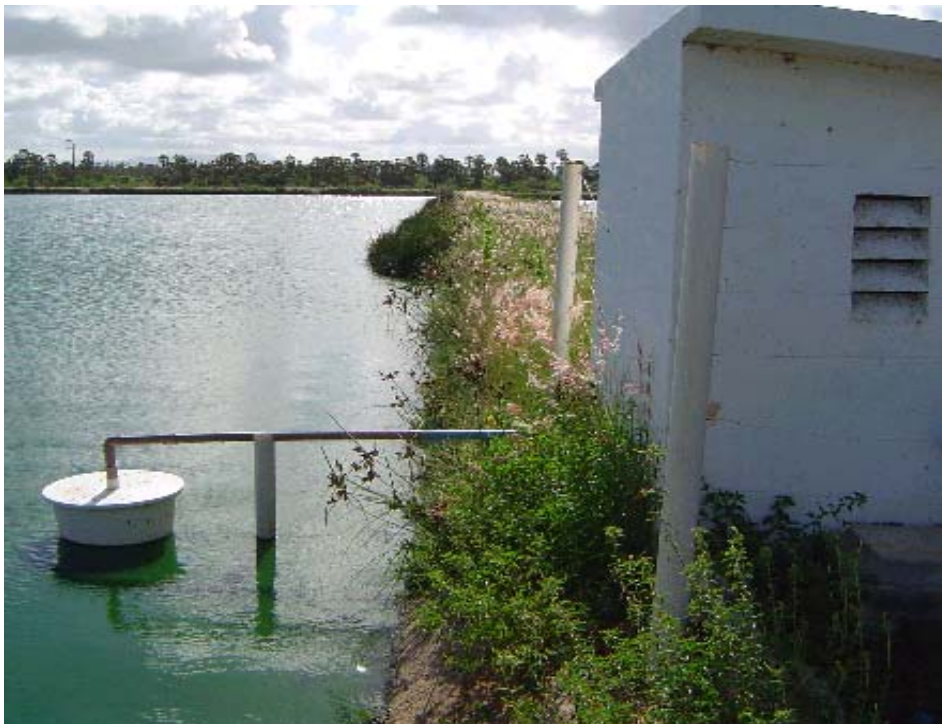
FIGURA 4.5 – Captação de esgoto tratado na lagoa de maturação. Aquiraz, Ceará, 2006.
