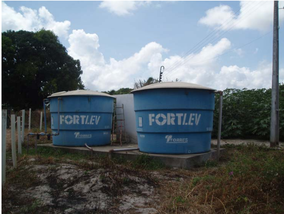
FIGURA 4.6 – Reservatórios de água e de esgoto tratado da área de pesquisa. Aquiraz, Ceará, 2006.
