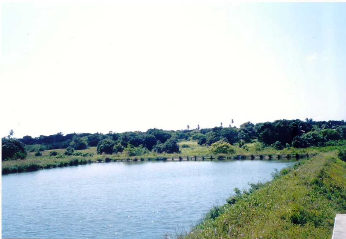
FIGURA 4.4 – Lagoa de maturação da ETE de Aquiraz, Ceará, 2006.
