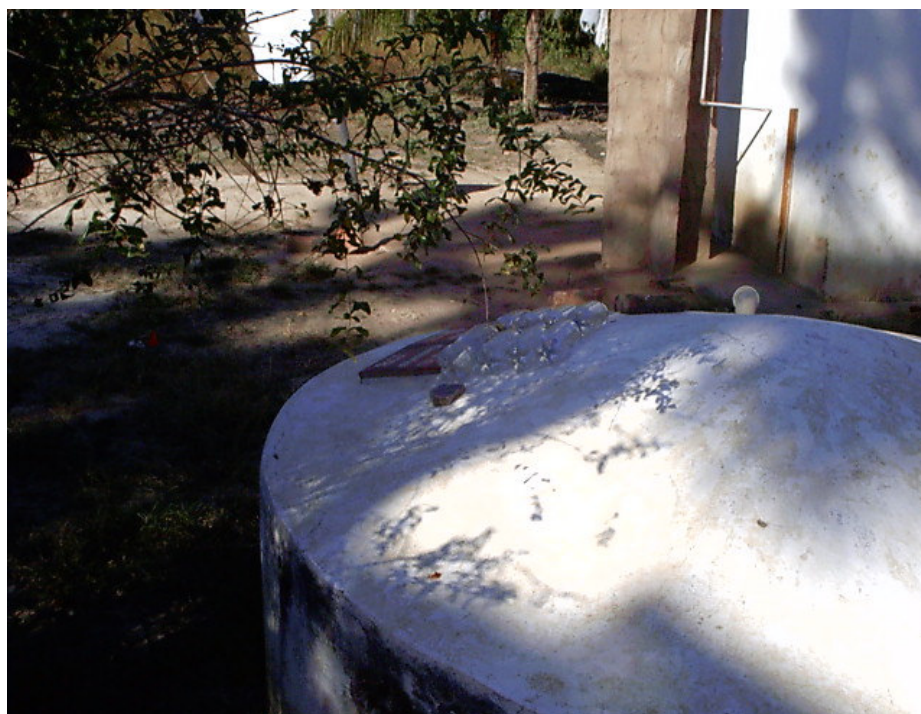
Figura G 4 - Garrafas expostas à radiação sobre cisterna de placas de forma equivocada, em locais sombreados.
