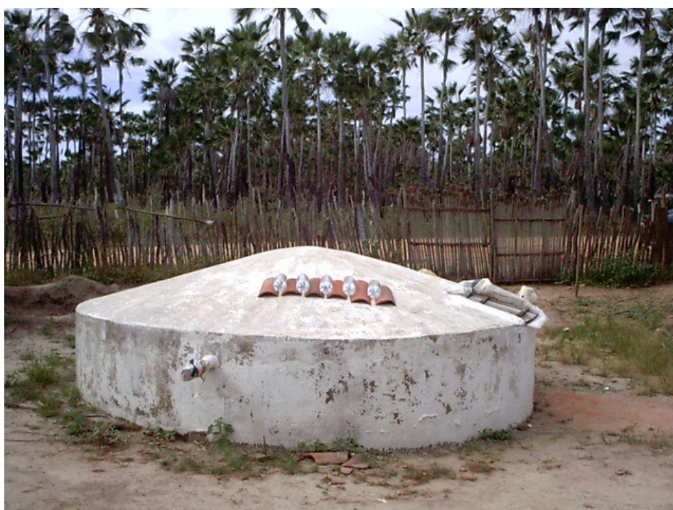
Figura G 2 - Garrafas SODIS expostas sobre a cisterna de placa em Camurim
