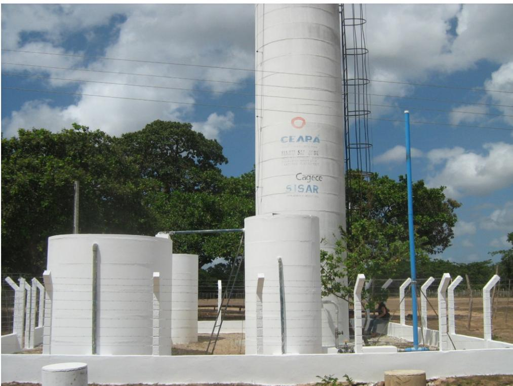
Figura 5.5 - ETA com a tecnologia Filtração Direta Ascendente da localidade de Batatas, em Tururu. Captação – Rio.
