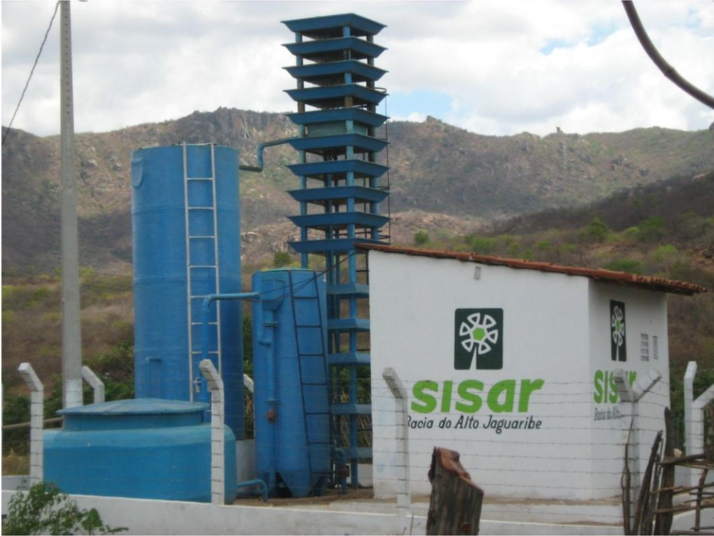
Figura 5.4 – ETA com a tecnologia Ciclo Completo da localidade de Varzinha, em Icó. Captação – poço.
