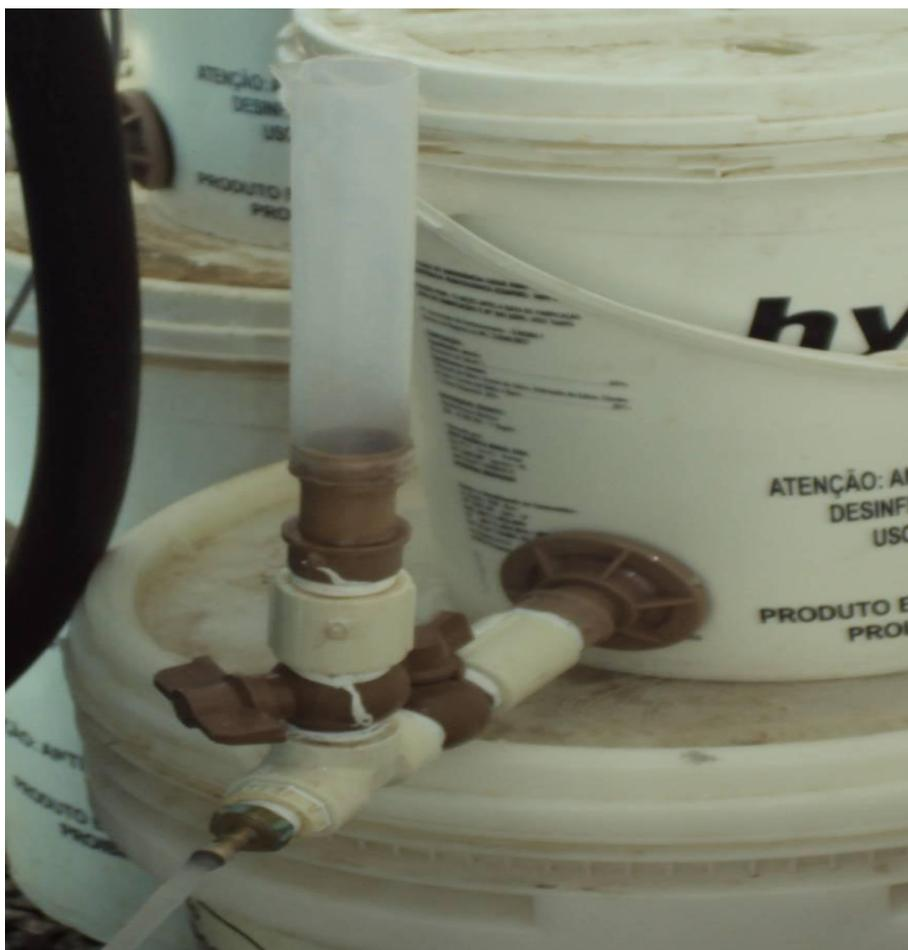
Figura 3.5 – Medidor de vazão do sistema de dosagem
