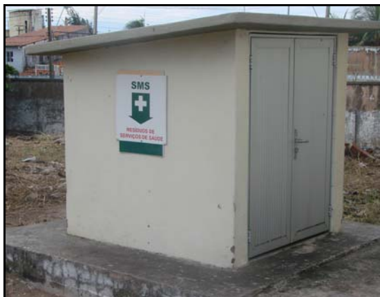
Fonte: Lubnor. Fortaleza – CE. 2009. FIGURA 4.10 – “Casinha” para armazenamento de resíduos sólidos de serviços de saúde
