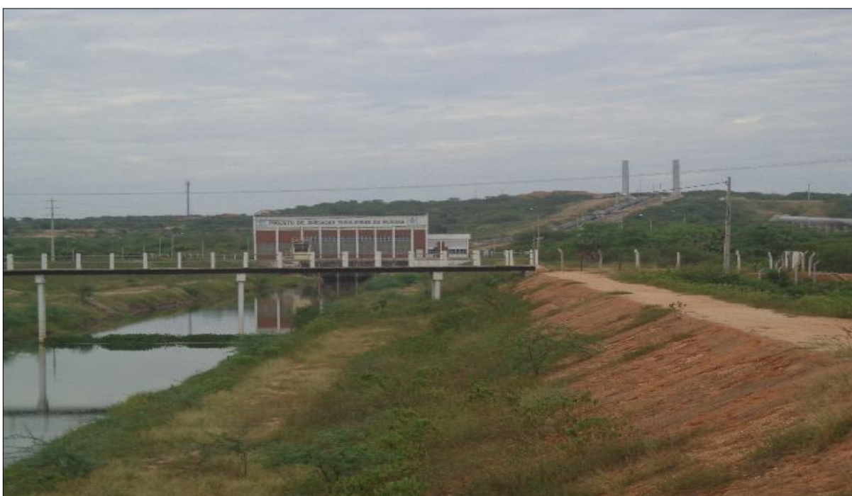
Visita ao Canal de aproximação Estação de Bombeamento Distar – fornecimento de água para o perímetro irrigado de Tabuleiro de Russas
