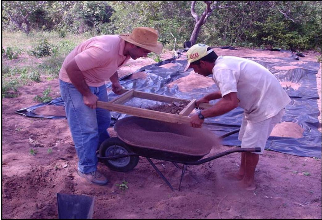
FIGURA 3.13 – Coleta de solo do local e retirada de partículas maiores que 2 mm com auxílio de uma peneira de construção civil.
