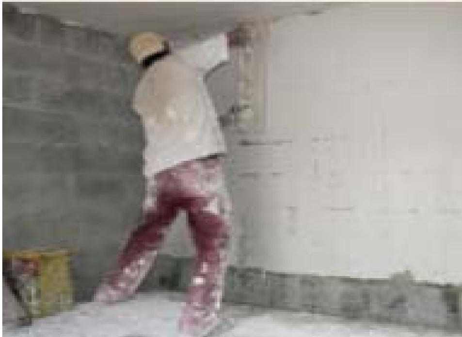
FIGURA 3.3 – Aplicação de pasta de gesso em paredes, sentido horizontal (obra 04).
