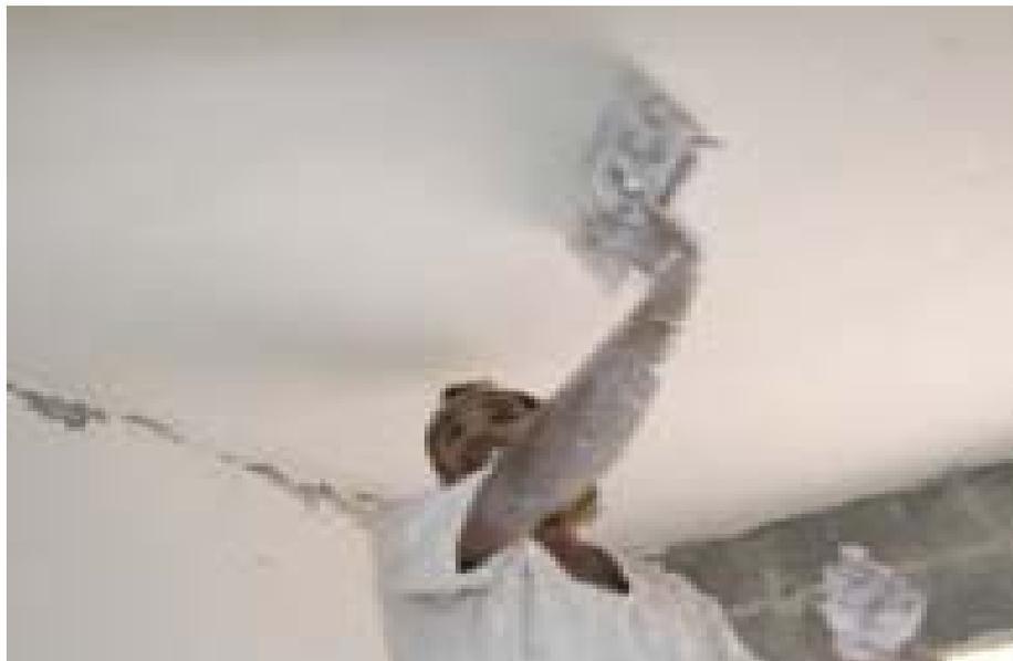
FIGURA 3.6 – Acabamento final da superfície (obra 04).
