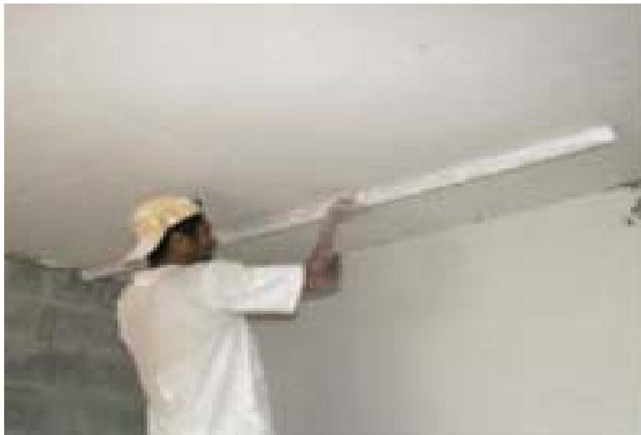
FIGURA 3.4 – Nivelamento da superfície revestida (obra 04).
