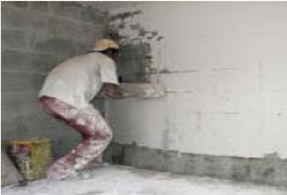
FIGURA 3.2 – Aplicação de pasta de gesso em paredes, sentido vertical (obra 04).
