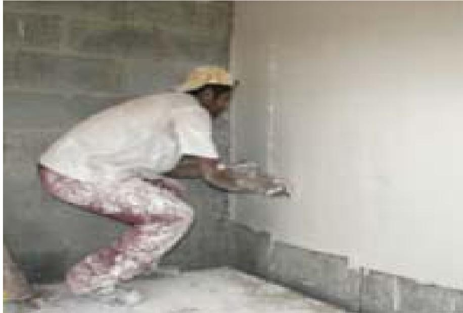
FIGURA 3.5 – Superfície homogênea, sem vazios e imperfeições (obra 04).
