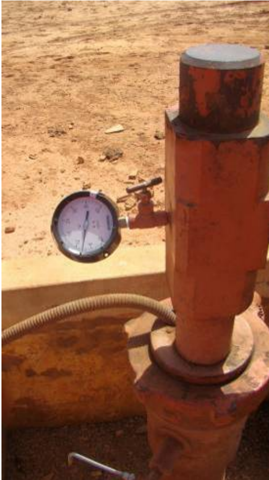
Figura 5.27. Medidor de pressão em três momentos: 1) com a bomba desligada (pressão nula); 2) durante o enchimento da adutora (pressão 8 kgf/cm 2 ) e 3) durante o enchimento do reservatório, quando a pressão se estabilizou em 11 kgf/cm 2
