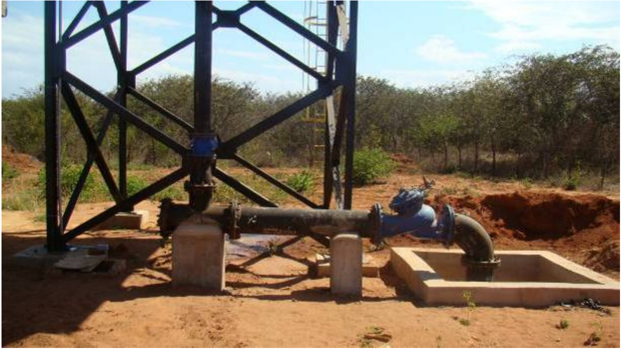
Figura 5.28. Final da adutora de ferro fundido, chegando à torre de resfriamento
