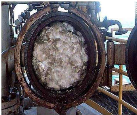
a) Hidrato no interior da linha.
